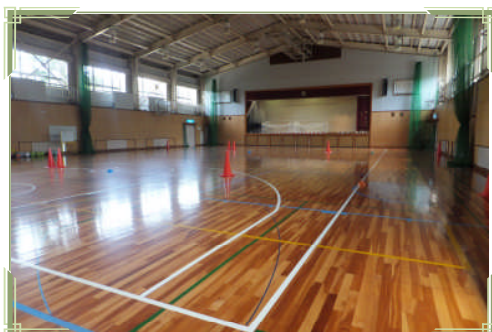
改修された体育館フロア
