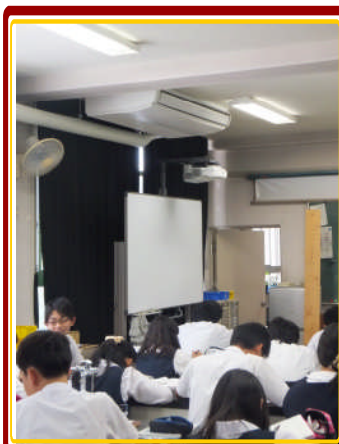
理科室空調設備の新設
